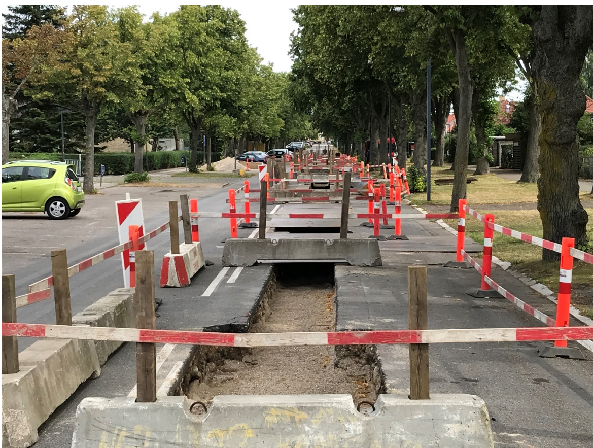
Foto: Omlægning af hovedledning i Hendriksholms Boulevard, set fra Rødovre Stationsvej.
