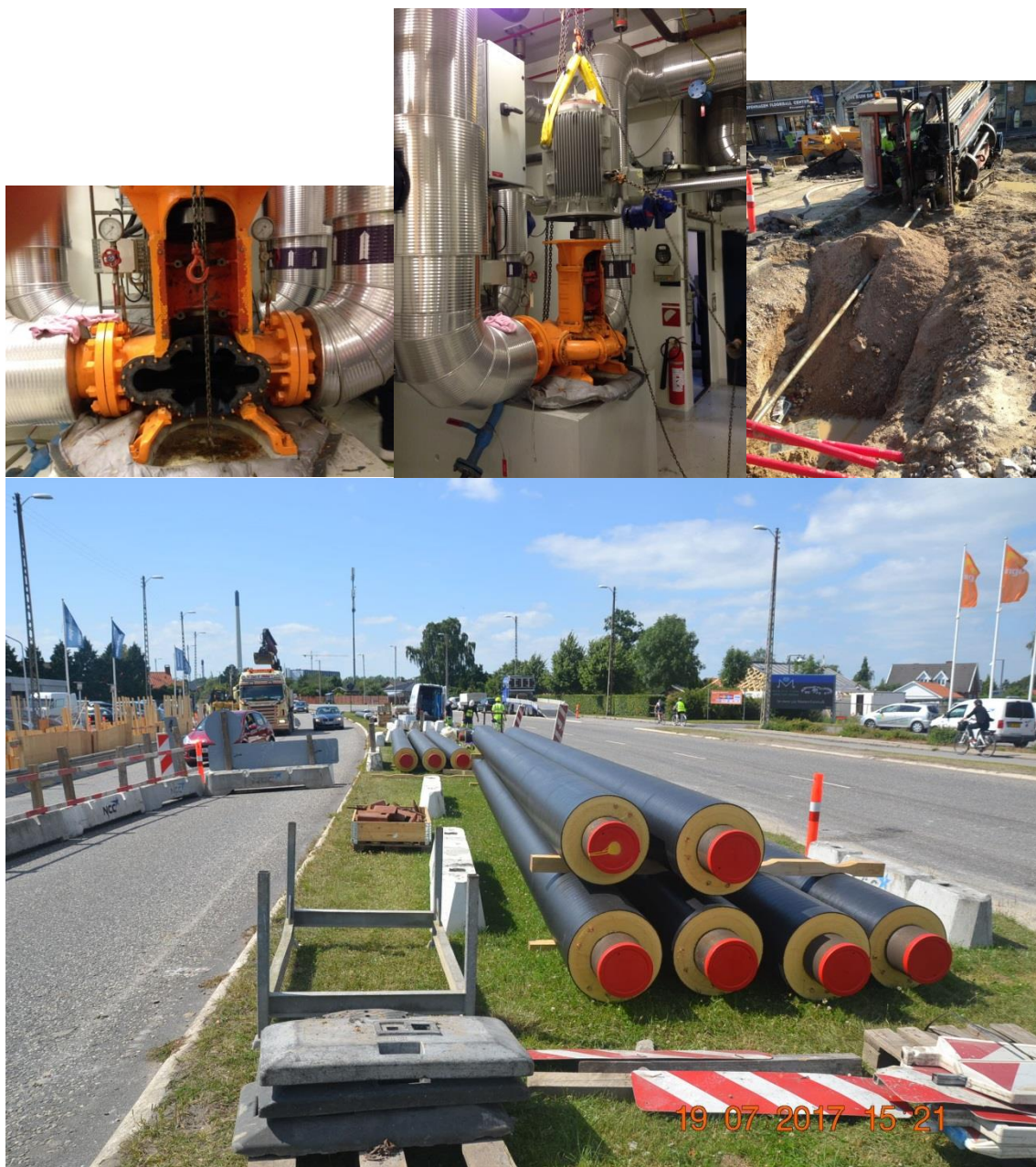
Foto: Åbent pumpehus inden montering af nyt skovlhjul, Vekslerstation Bybjerget. Montering af kraftigere motor på pumpe, Vekslerstation Bybjerget. Styret underboring fra Damhustorvet til Damhusparken. Krydsning af Slotsherrensvej, udbygning til erhvervs kvarteret Islevdalvej.
