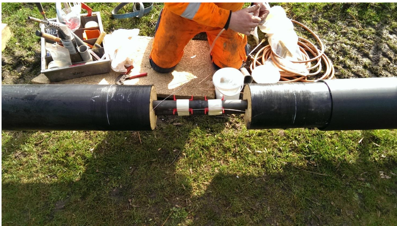
Foto: Samling af alarmtråde under udbygningen i erhvervsområde Valhøj. Alarmtrådene bruges til at detektere evt. utætheder i rørene.
